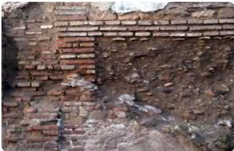
Imagen de muro en el que se combinan el empleo del tapial con grava, el ladrillo y la piedra
