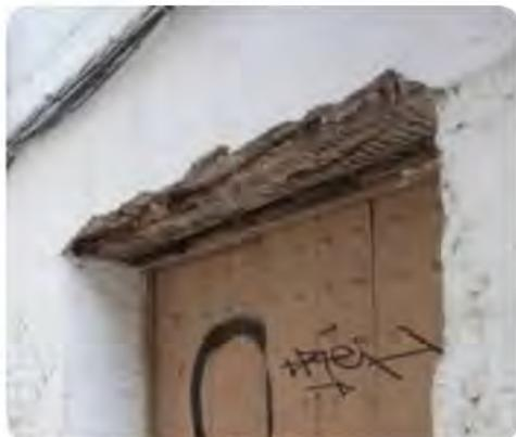
Deformación excesiva de dintel
